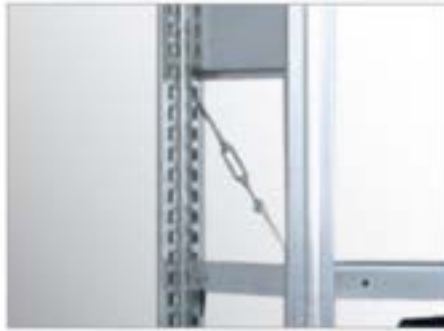
Kreuzdiagonale als Feldaussteifung
